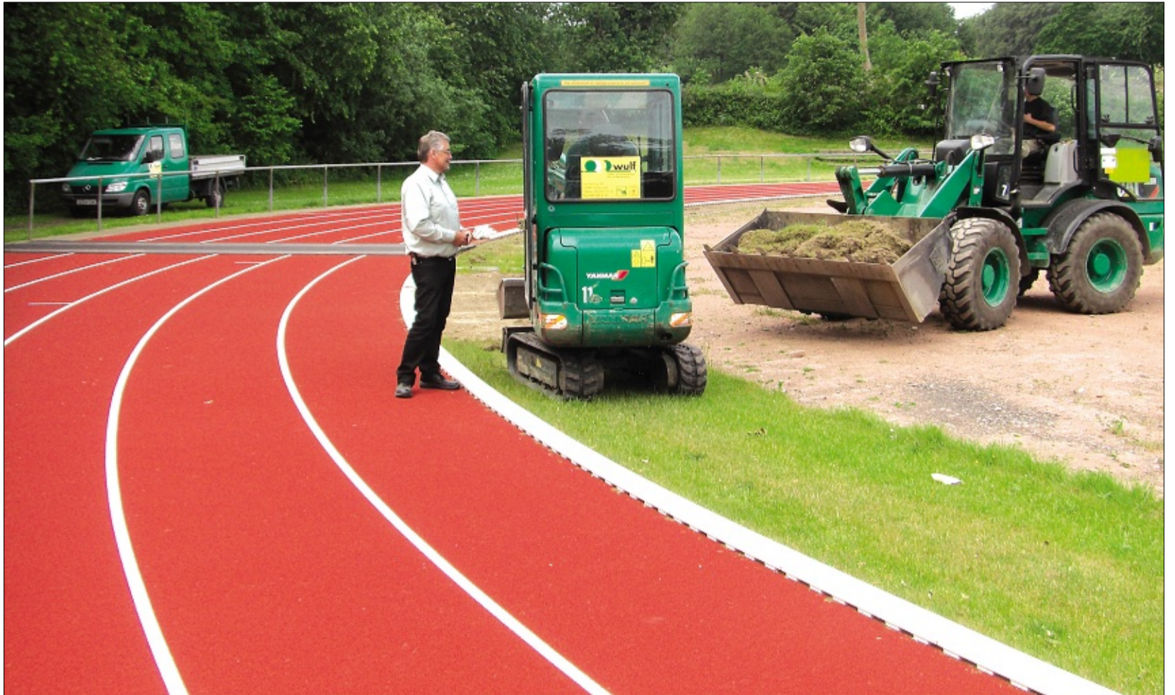
Die Läufer haben schon freie Bahn, jetzt erfolgte der Baubeginn für einen weiteren Leichtathletikbereich.
